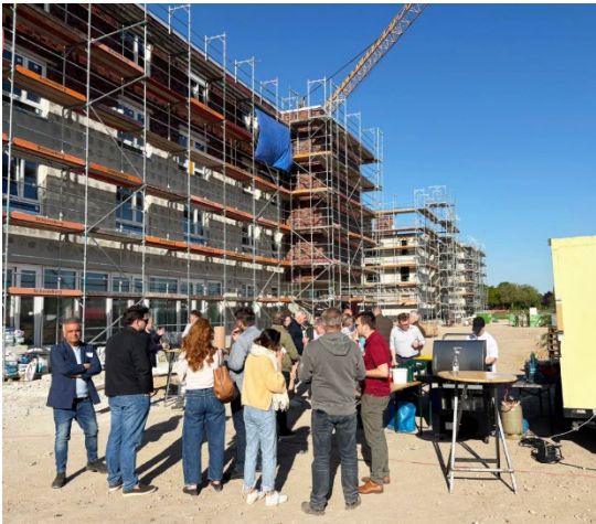
Mit einem zünftigen Barbecue schließt die Baustellenbesichtigung des Stiftscampus am Schmeddersweg ab.
